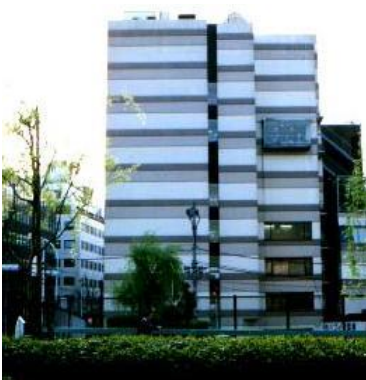
本社ビル(中央区銀座)
